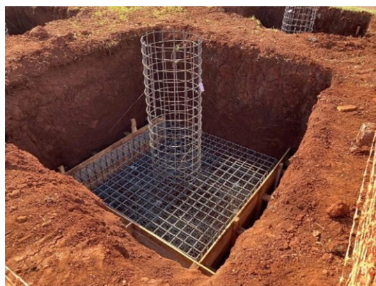
Figura 1: Cimentación. Fuente: San Marcos, 2024
