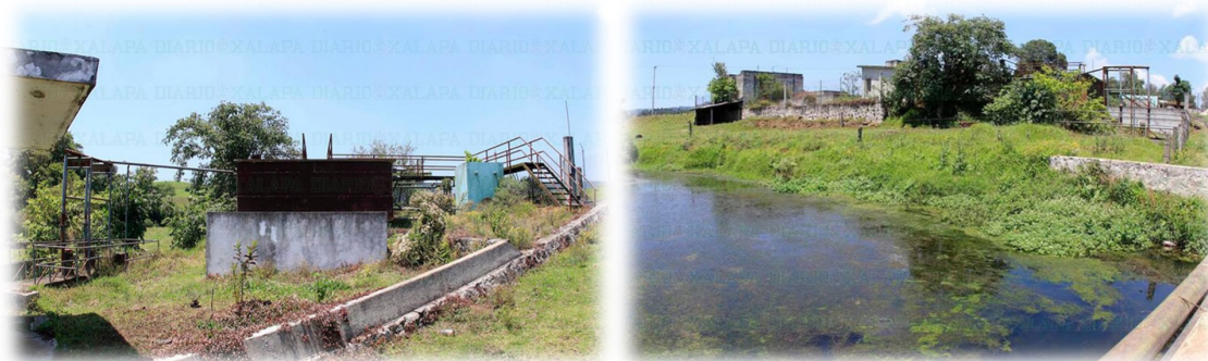
Figura 1. Planta de tratamiento de aguas residuales
