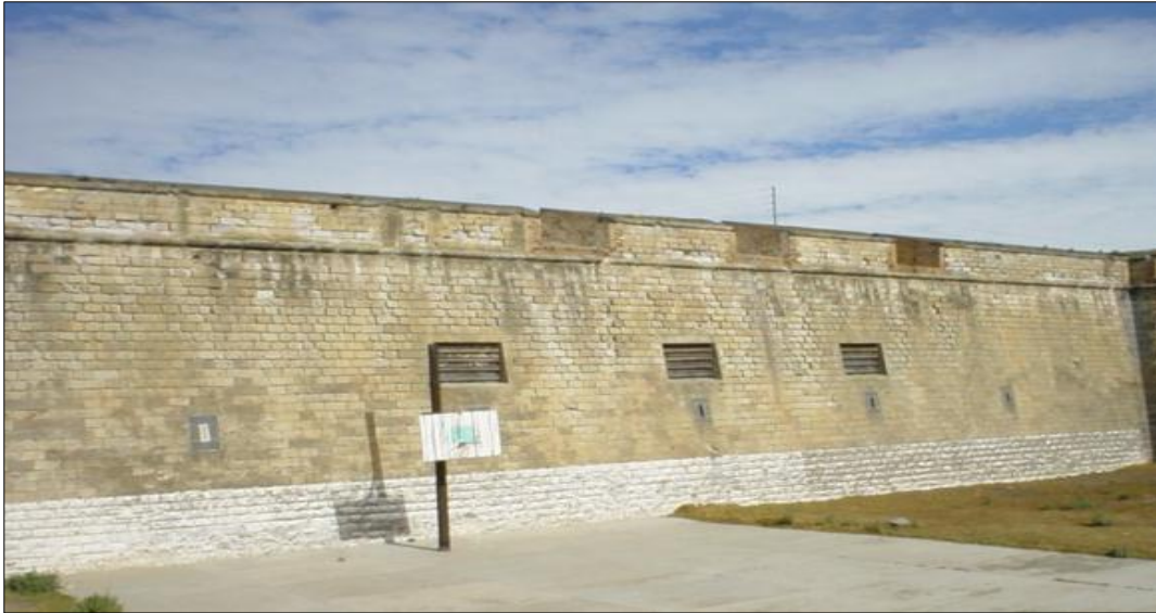
Figura 7. Muro Fortaleza de San Carlos
