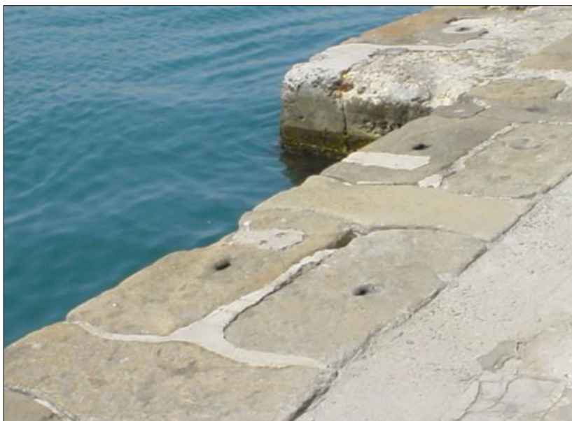
Figura 4. Banqueta muro de las argollas
