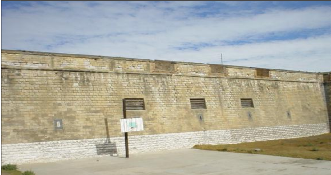
Figura 7. Muro Fortaleza de San Carlos
