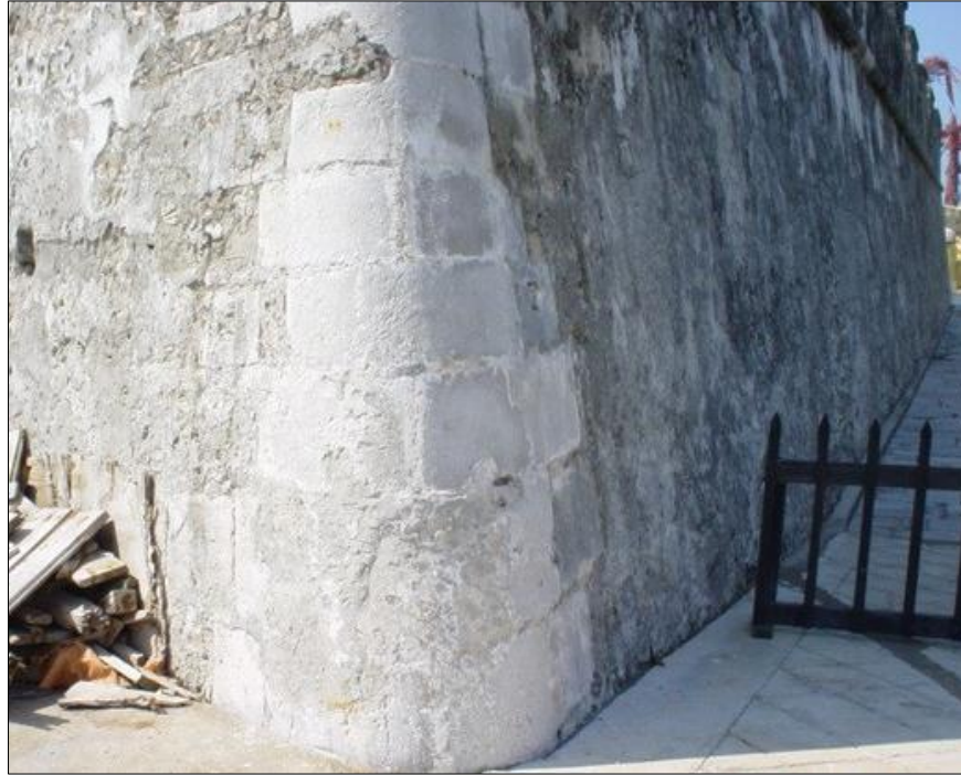
Figura 5. Muro Baluarte San Crispín
