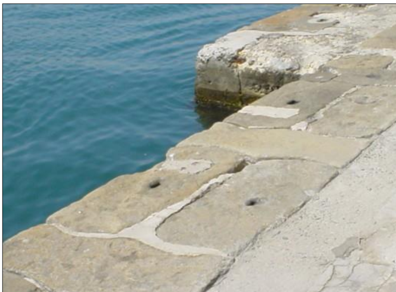
Figura 4. Banqueta muro de las argollas
